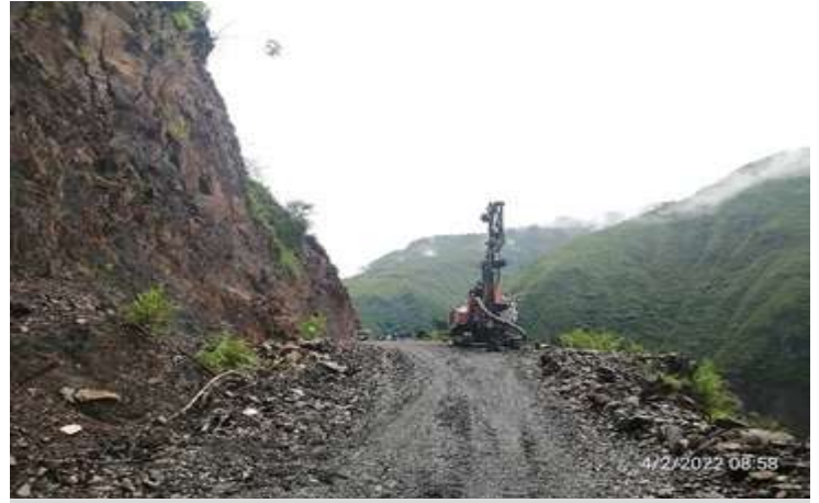
Trabajos de perforación con drill PK 3+900 Camino (Conexión Mineros-CH Palillada)
