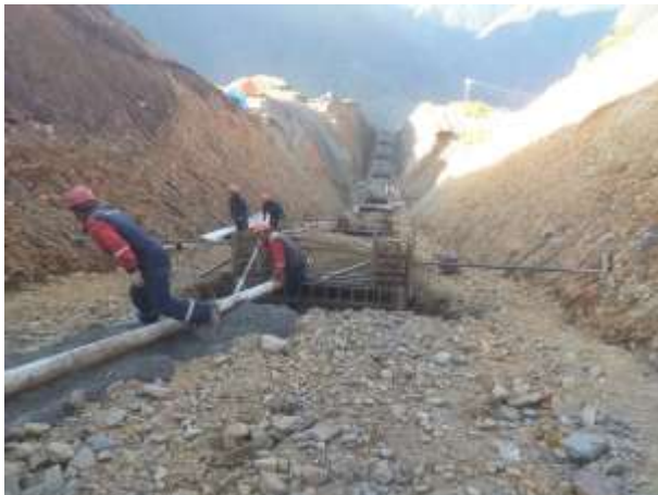
Sistema Umapalca 29-03-22 Obras Superficiales - Tuberia Forzada- Hormigonado de Silletas 2da.Etapa T V4-V6
