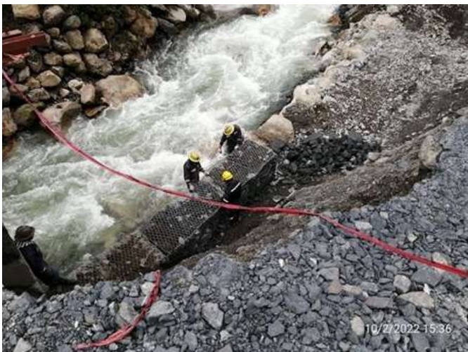
Construcción de Muro Gavionado para Protección de Puente Frente Carabuco
