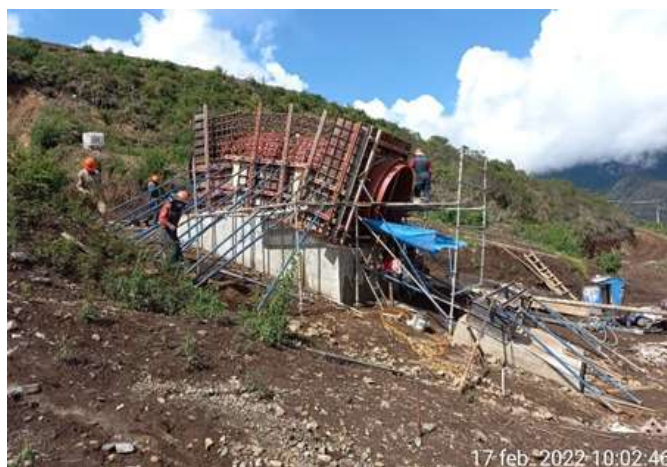
Tubería Forzada Umapalca, Encofrado de Bloque de Anclaje (V-1).
