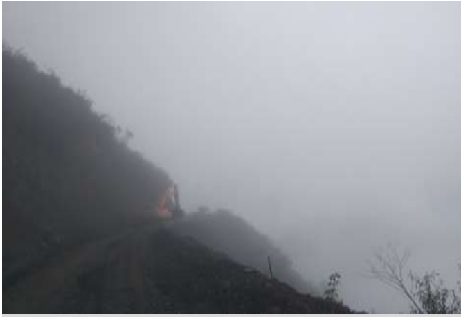
Sistema Umapalca 30-03-22 Obras Superficiales - Vías de Acceso- CCU - CHU Limpieza y Conformación de Plataforma Tramo 0+900
