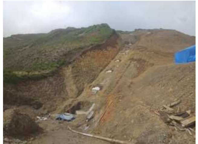
Sistema Umapalca 31-03-22 Obras Superficiales - Tuberia Forzada-Hormigonado de Silletas 2da.Etapa T V4-V6
