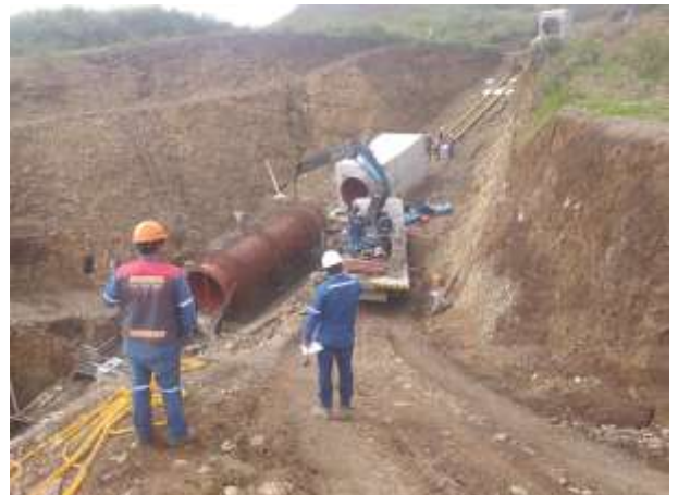
Sistema Umapalca 02-04-22 Obras Superficiales - Tuberia Forzada-Armadode enferradura 2da.Etapa Vertice V3
