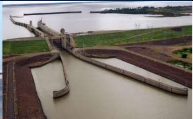
Esclusa de Navegación – Vista Aérea
