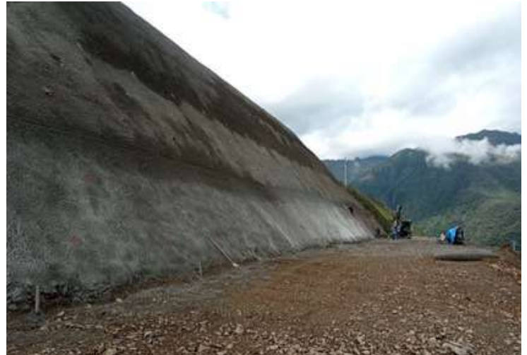
Colocación de protección y soporte de talud en cámara de carga
