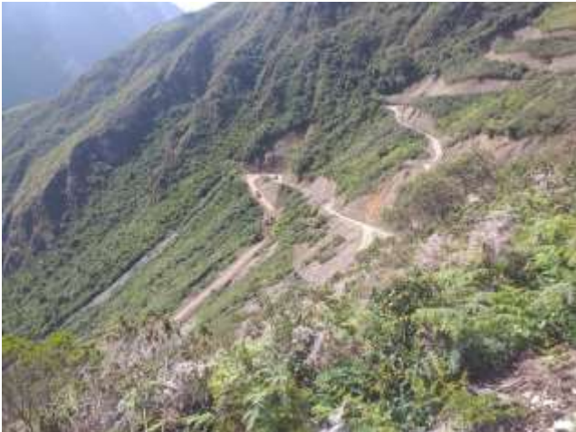
Sistema Umapalca 30-03-22 Obras Superficiales - Vías de Acceso- CCU - CHU Limpieza y Conformacion de Plataforma Prog 0+750
